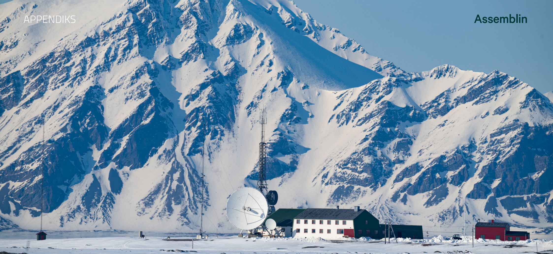
Isfjord radio hotell og restaurant, 90 kilometer fra Longyearbyen, er én av virksomhetene hvor Assemblin Spitsbergen har levert bærekraftige og miljøvennlige energiløsninger.
